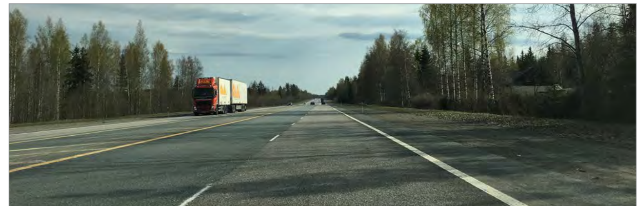
Kuva 2-6. Joutsan kuntakeskuksen pohjoispuolella sijaitseva valtatie-n 4 varalaskupaikka.
