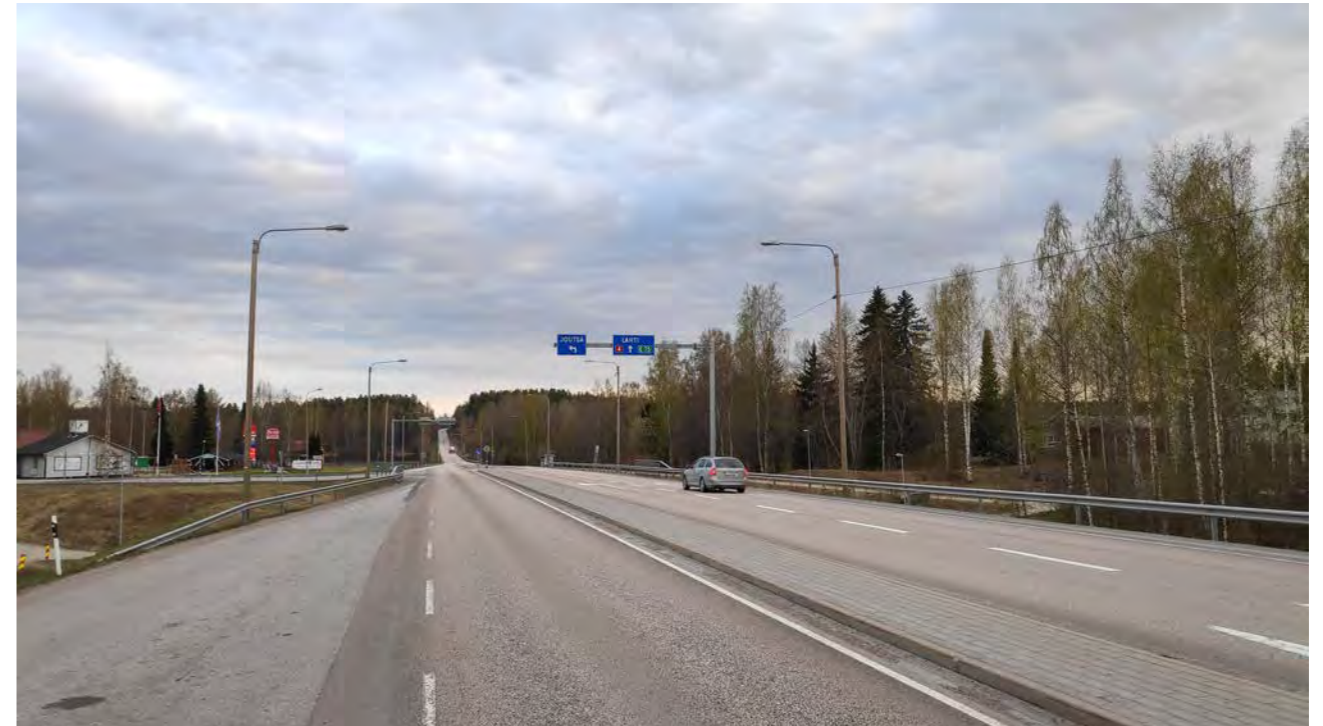
Kuva 2-15. Nykyiset tasoliittymäjärjestelyt eivät mahdollista valtatielle asetettua nopeustavoitetta 100 km/h.
